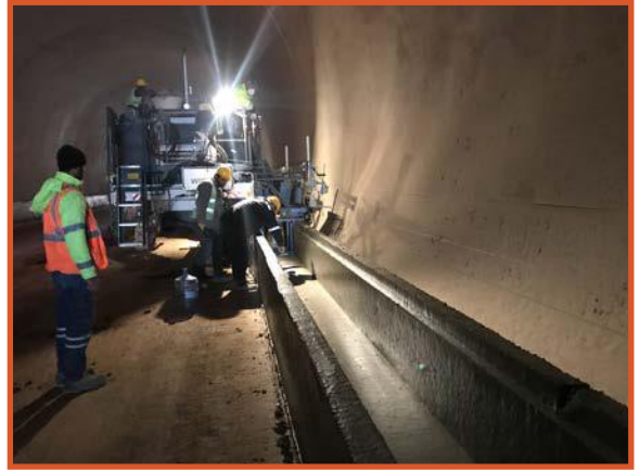
Kablo Kanalı Uygulaması
