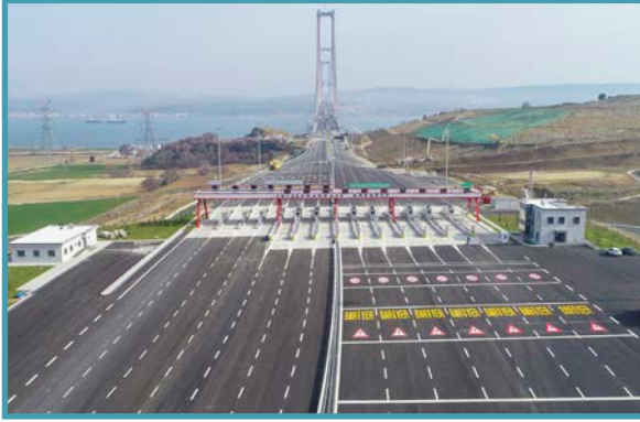
Otoyol Gişre İnşalarında
