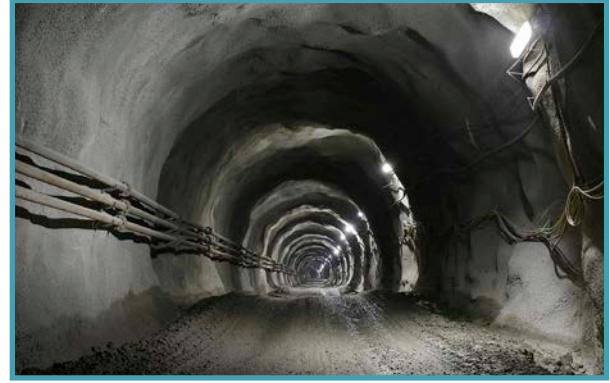
Madenlerde Püskürtme Beton Uygulaması
